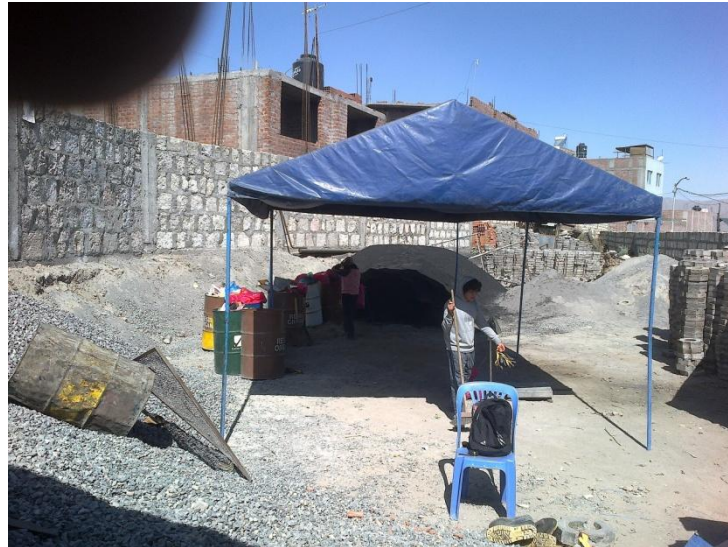
Fig. N° 2. Terreno de San Basilio que sirvió como centro de acopio para realizar el estudio de caracterización
