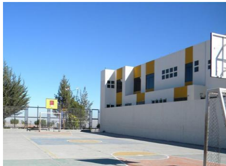
Inicio de Obra
