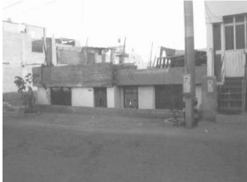
Inicio de Obra
