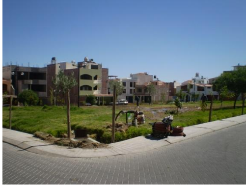
Inicio de Obra
