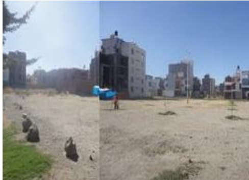
Inicio de Obra
