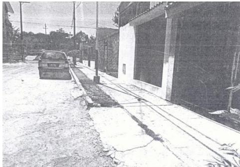
Inicio de Obra
