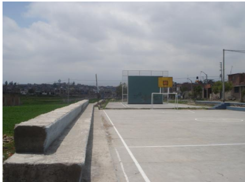
Inicio de Obra
