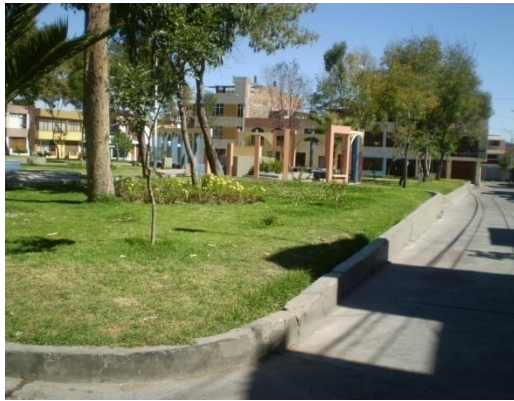
Inicio de Obra
