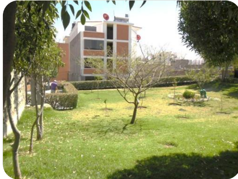
Inicio de Obra
