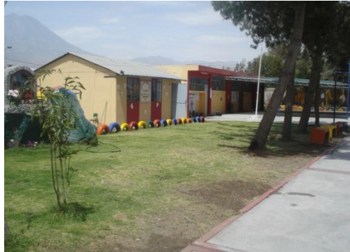
Inicio de Obra
