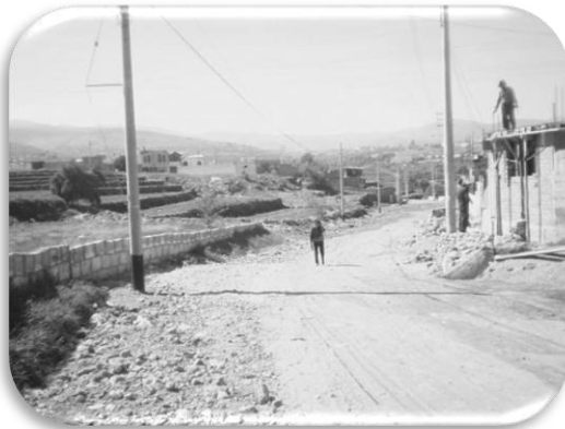
Inicio de Obra
