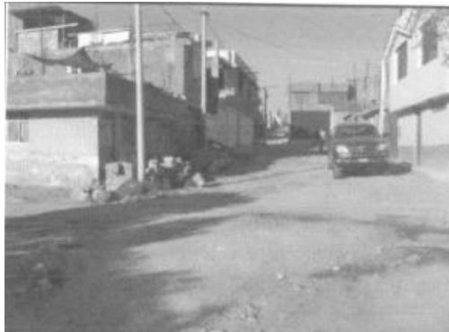
Inicio de Obra
