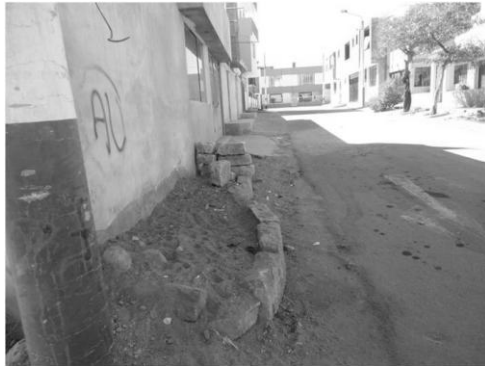
Inicio de Obra
