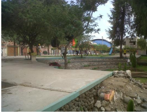
Inicio de Obra
